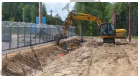
Устройство водоотводной канавы на УП КС «Волховская»
